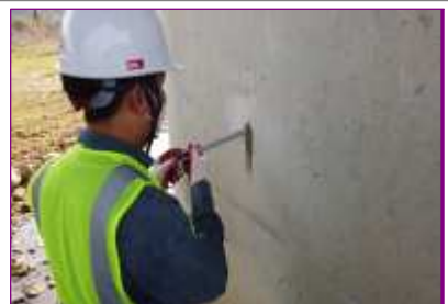
탄산화 깊이 측정
